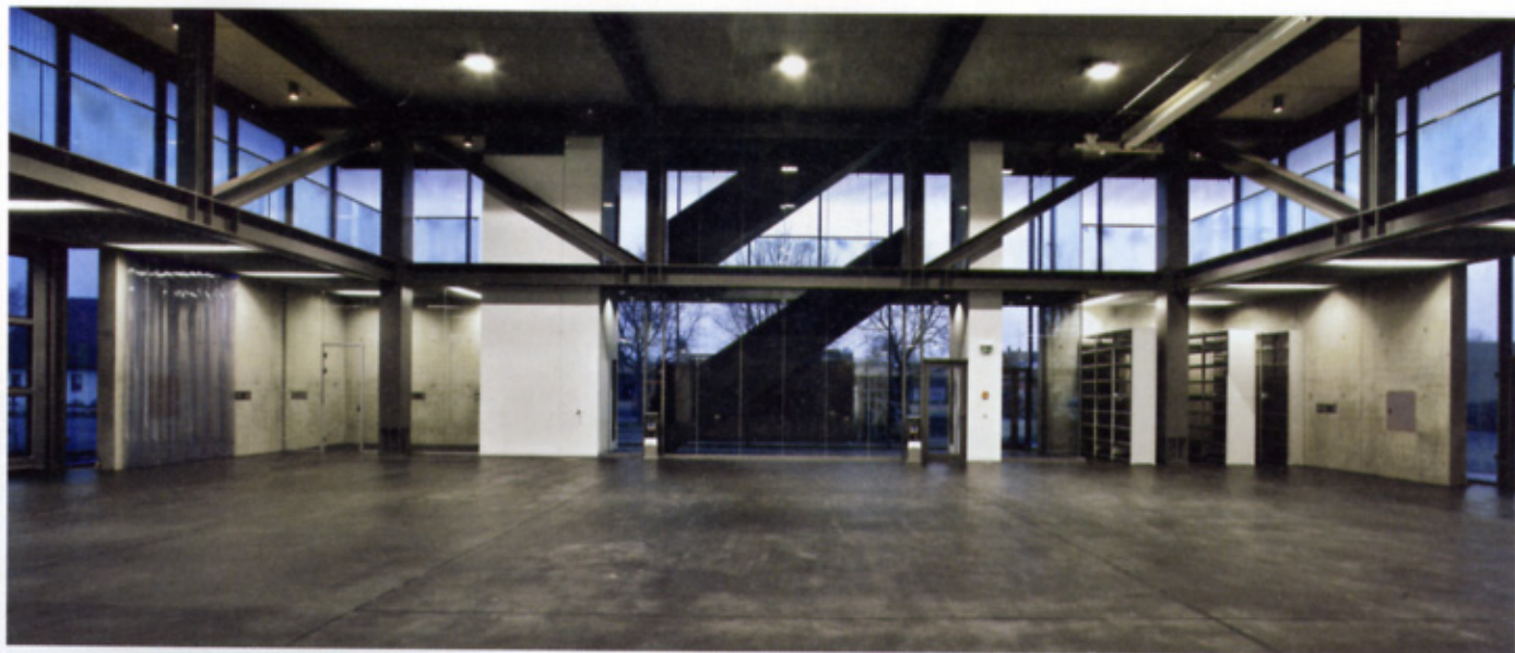
Die Großgerätemontagehalle im stützenfreien Erdgeschoss.
